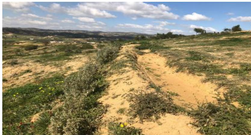
Avec une longueur totale de 700 m et une capacité de rétention d'eau de 0,4m<sup>2</sup>/m, une récupération totale d'eau de pluie estimés au 280 m<sup>3</sup>/an
