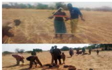
Mise en place de cordon pierreux à l'aide d'un niveau « Grand A »
