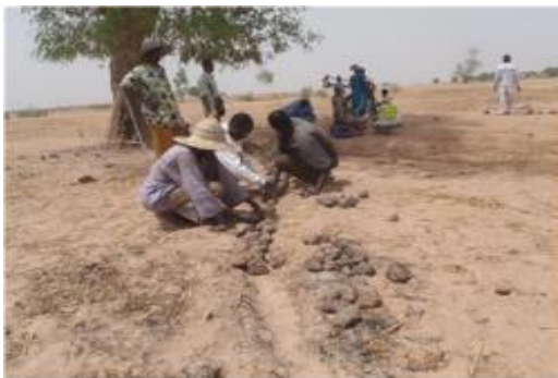
Construction de barrières en pierre (photo : JICA)
