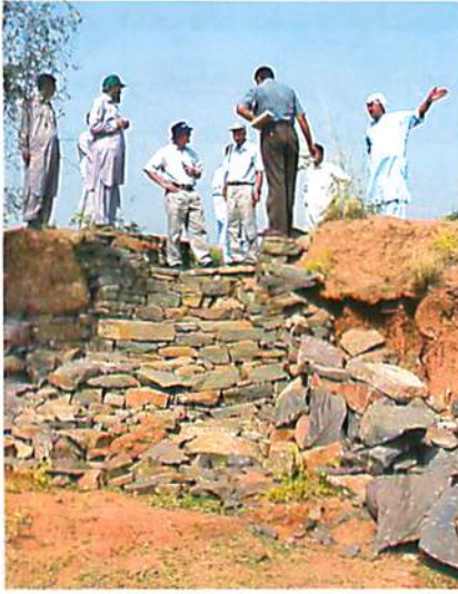
بنى بسيطة ومجدية اقتصادياً لتنظيم جريان المياه صممها المشروع ونفذها المزارعون لمكافحة الانجراف وإدارة مياه الأمطار.
