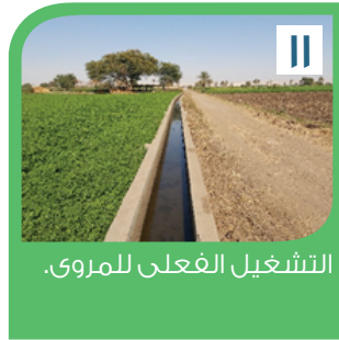
٨ اختبار المروى قبل التشغيل للتأكد من سريان المياه والميول والتسريب وكفاءة عمل البوابات.
