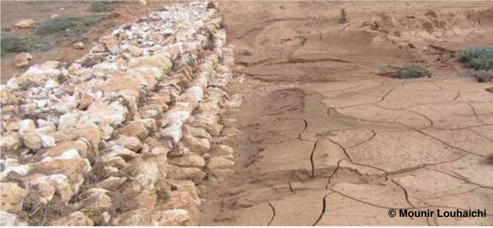
الشكل 2. جدار حجري للسيطرة على التآكل الناتج بسبب المياه
