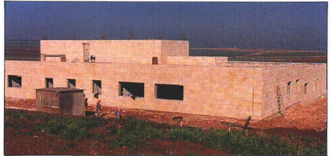
مبنى الأصول الوراثية الجديد في تل حديا وهو لا يزال قيد التشييد .
