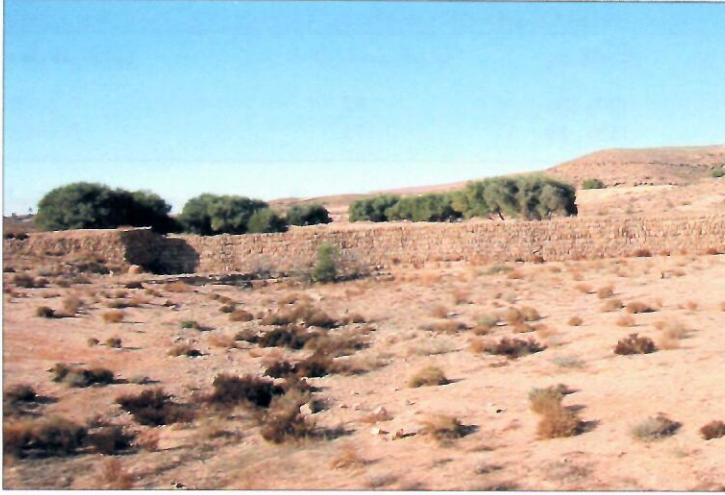
نظام الجسور لحصاد المياه في مسقط مياه أم زسار، تونس. وتزدهر أشجار الزيتون بفعل تجميع مياه الجريان السطحي والرواسب عند سد حجري.
