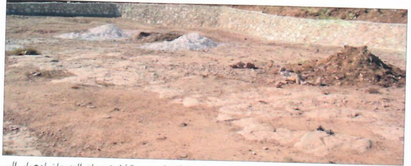
أحواض مائية صغيرة بنيت في مواقع المشروع في لبنان لجمع وتخزين مياه الجريان ليصار إلى استخدامها من قبل الحيوانات.
