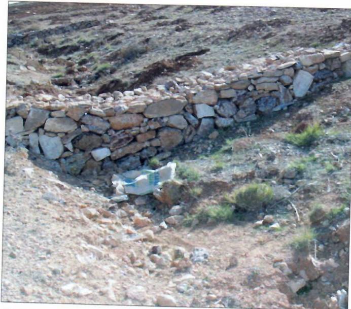
أثبتت منشآت شاهد مدنية الكلفة فعاليتها في إيقاف الجريان السطحي والاحتفاظ بالتربة التي يحملها هذا الجريان.
