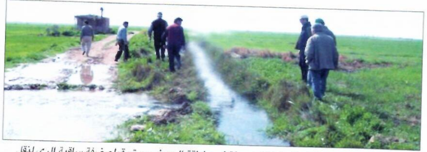
منشآت وممارسات نقل المياه ذات إدارة ضعيفة في منطقة الحوض: وتم قطع ضفة ساقية الري لنقل المياه عبر الطريق إلى حقل آخر، الأمر الذي يسبب مشكلات الجريان السطحي الزائد.
