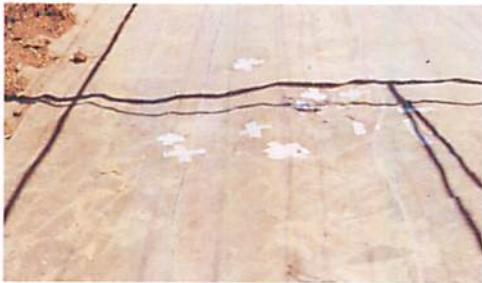
شكل رقم 10: في حالة حدوث ثقب بالبلاستيك لأي سبب كان، فإنه يجب إغلاقها بأشرطة لاصقة.
